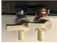
Exemple de vidange au point bas
