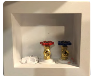
Raccords d'eau et de drainage du lave-linge
